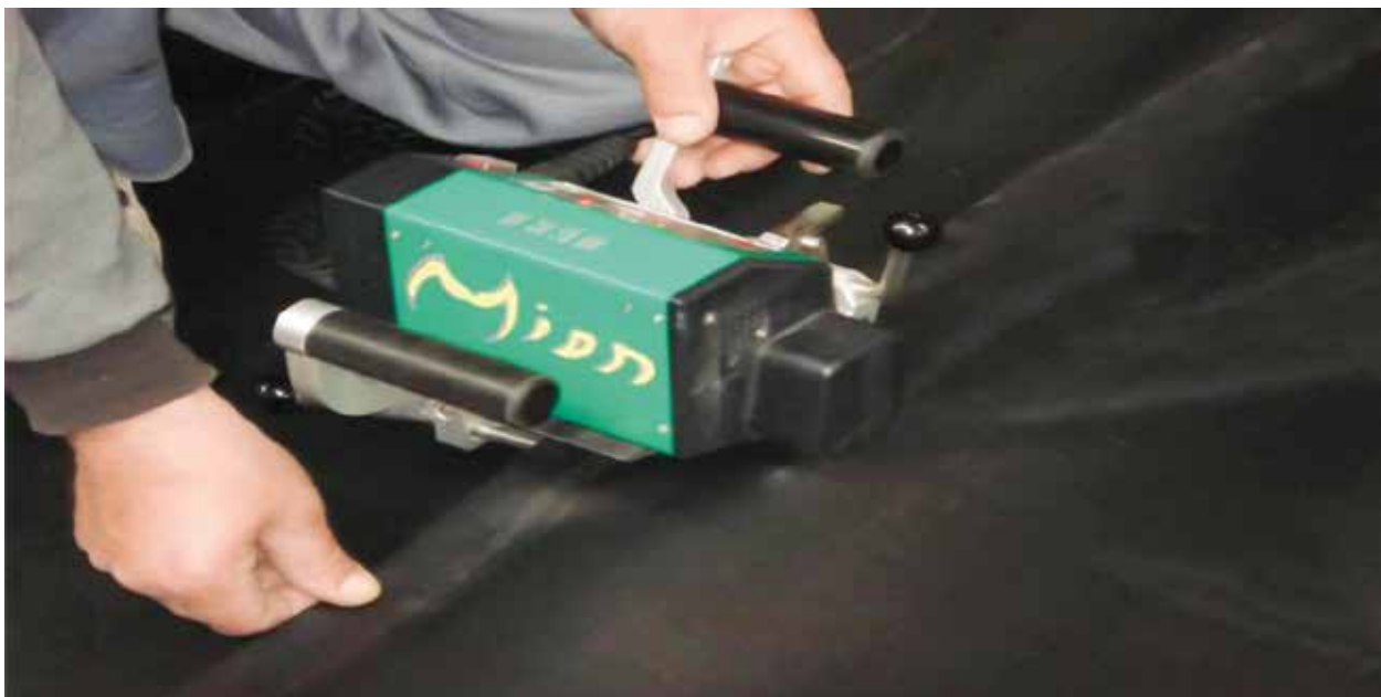
Выполнение сварки автоматическим сварочным роботом
