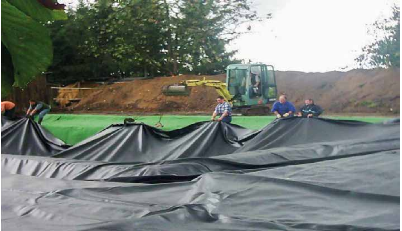
Укладка большой панели, подготовленной в соответствии с проектом водоема
