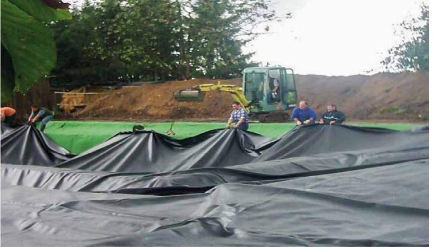
Gölet projesine uygun olarak hazırlanmış büyük panelin serilmesi
