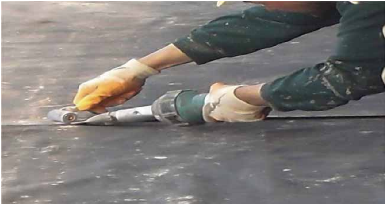
El kaynak makinesi ile yapılan bir uygulama
